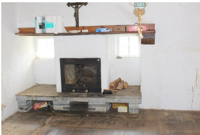
Wärmeluftheizkamin / camino aria calda
