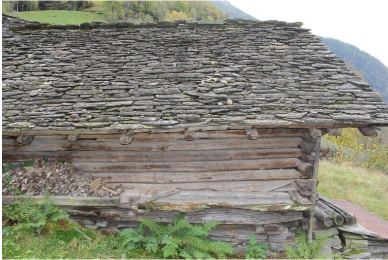
Seitenansicht West / vista casa ovest
