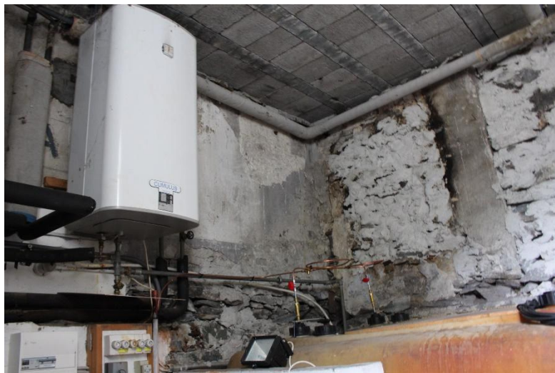
Keller – Technische Raum / cantina – locale tecnico
