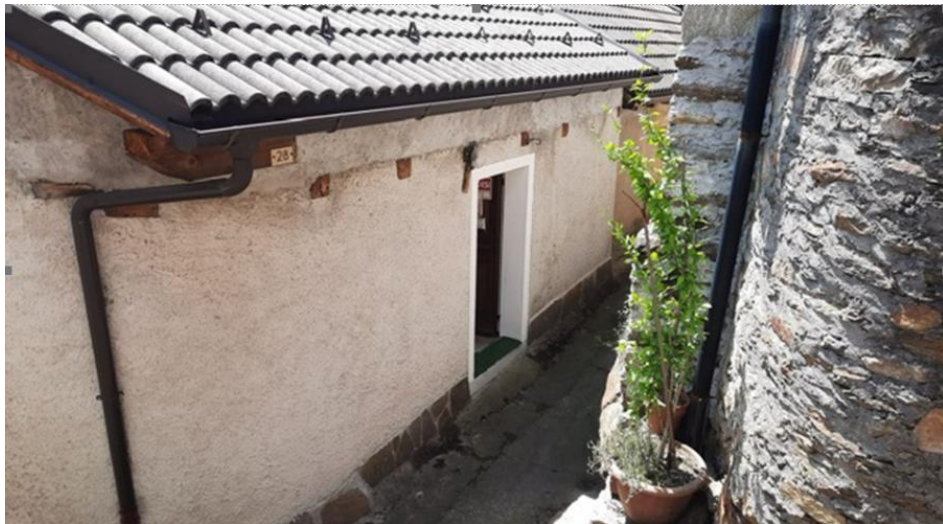
Dach neu / tetto nuovo
