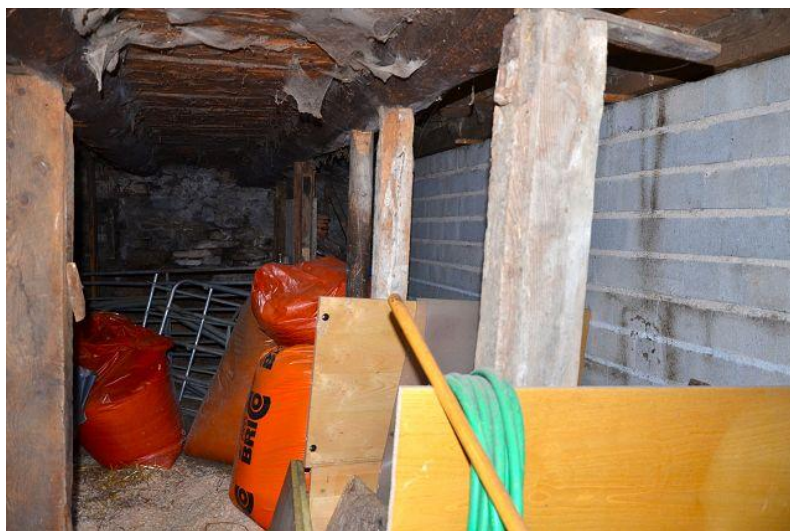
Innenbereich EG / interni PT
