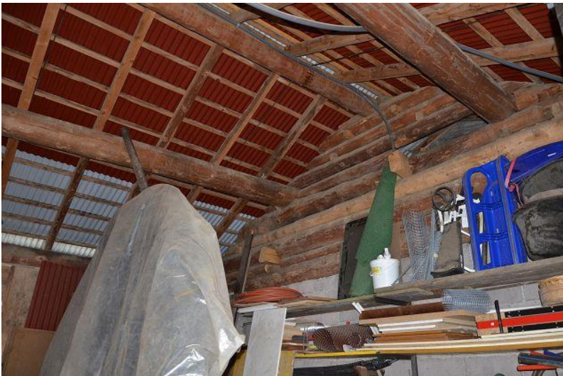
Innenbereich 1. OG / interni PP
