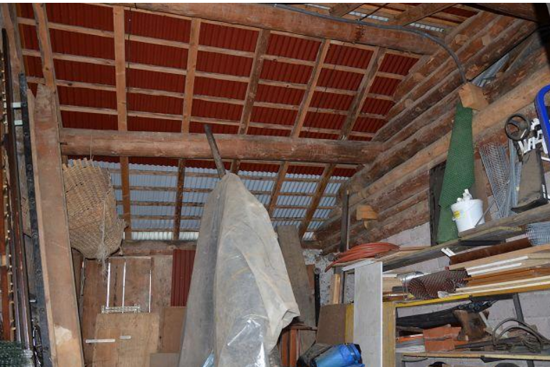
Innenbereich 1. OG / interni PP
