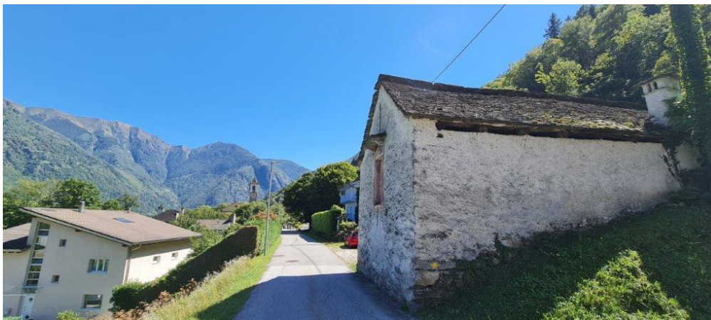
Hausansicht West / Vista casa ovest
