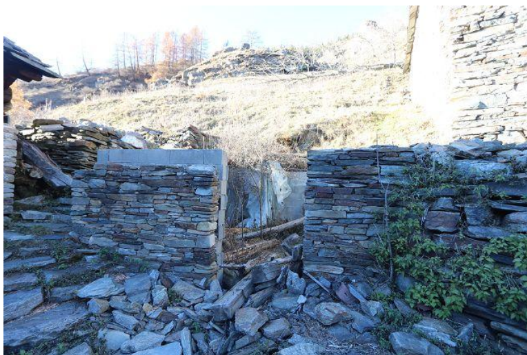
Kellermauern / muri della cantina
