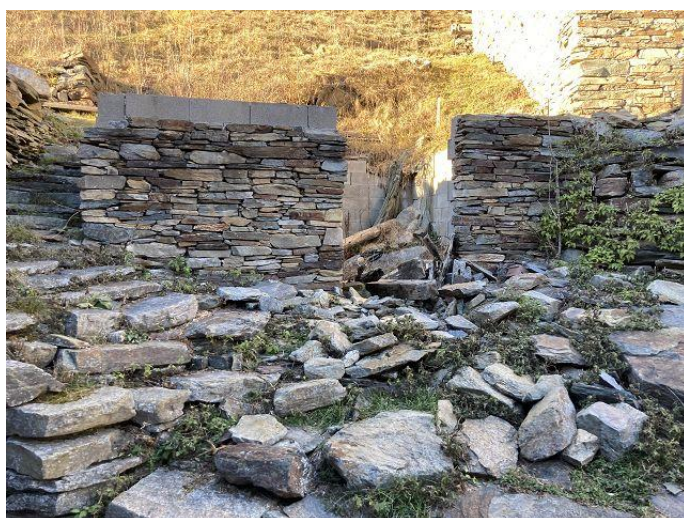
Kellermauern / muri della cantina
