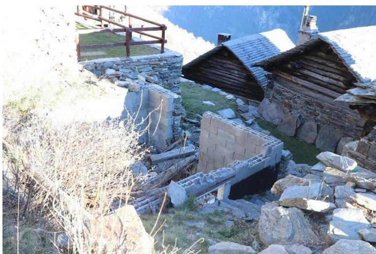
Kellermauern / muri della cantina
