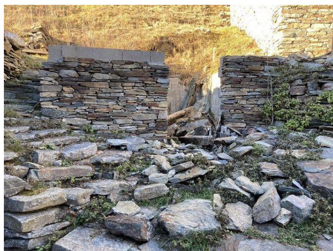
Kellermauern / muri della cantina
