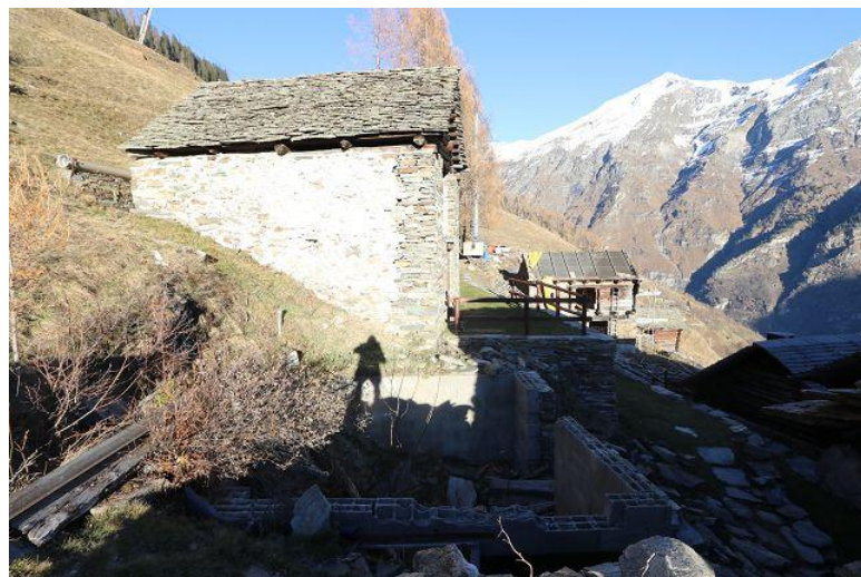
Blick nach Norden / vista verso nord
