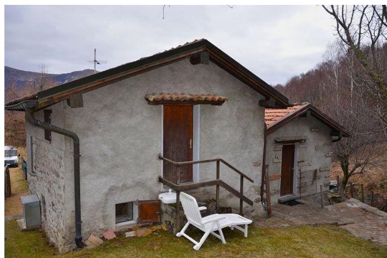
Beide Gebäude / due rustici
