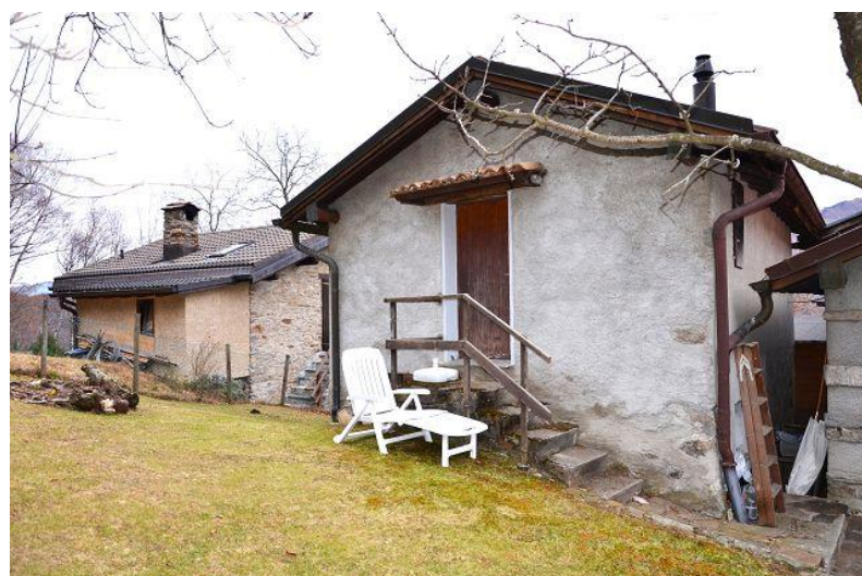
Rustico und Grundstück / rustico e terreno
