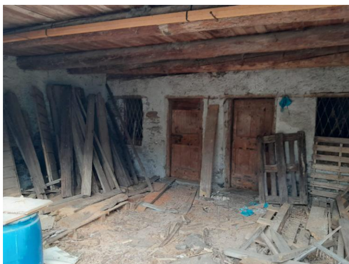
Innenraum Stall / interno della stalla
