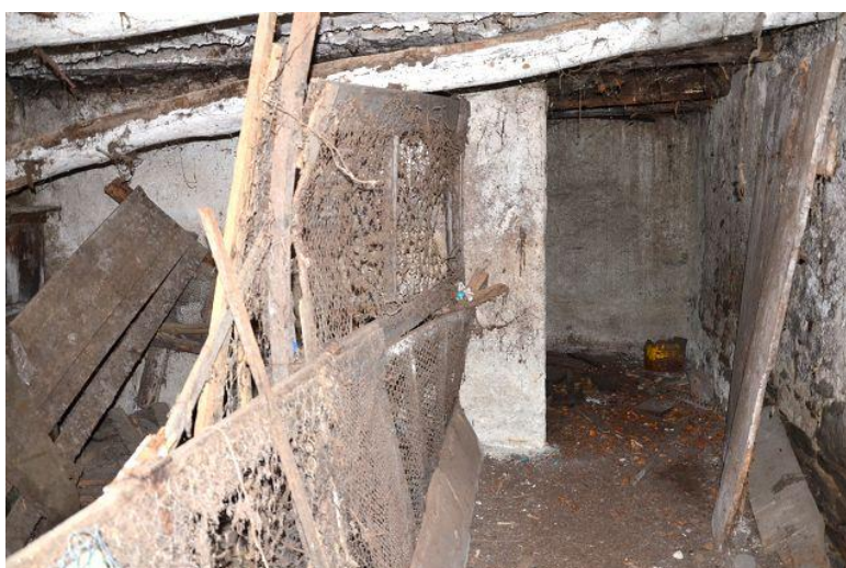
Innenraum EG / interno PT
