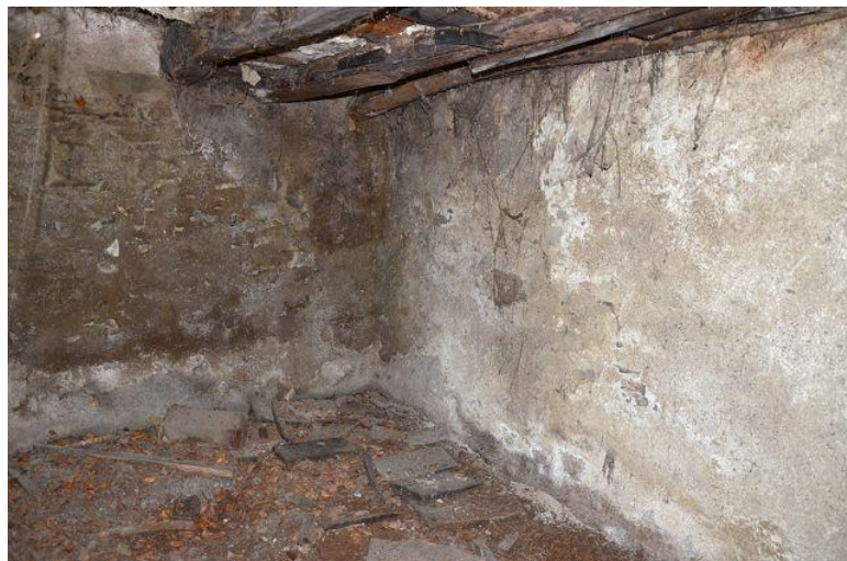
Innenraum EG / interno PT
