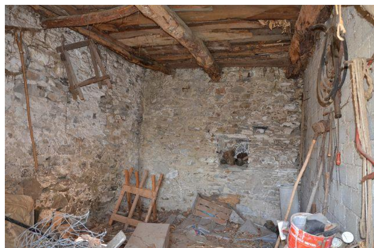
Innenraum EG / interno PT
