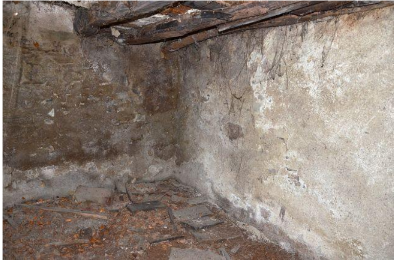
Innenraum EG / interno PT
