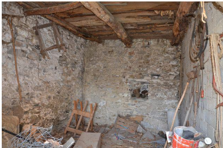
Innenraum EG / interno PT
