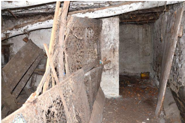
Innenraum EG / interno PT
