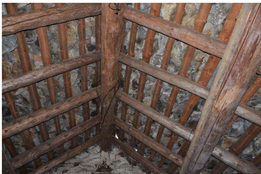
Dachuntersicht / sotto tetto
