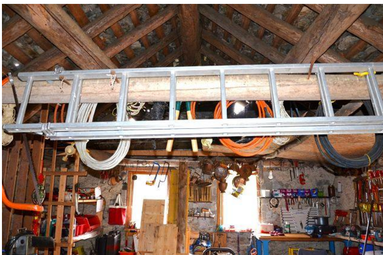
Innenraum 1. Obergeschoss / interno primo piano
