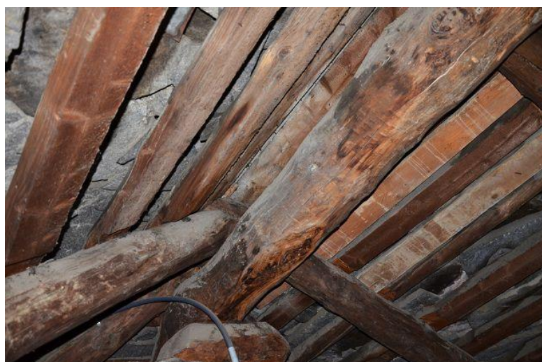
Dachkonstruktion / costruzione tetto
