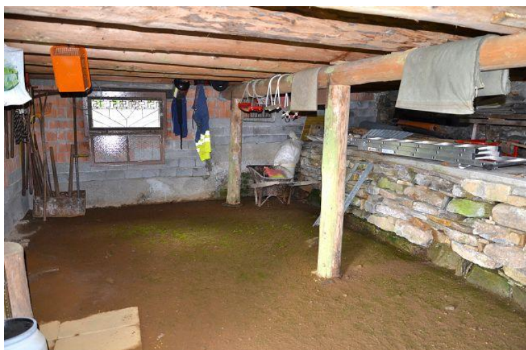
Innenraum Erdgeschoss / interno PT
