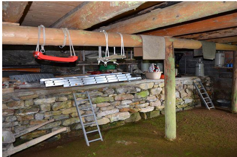
Innenraum Erdgeschoss / interno PT
