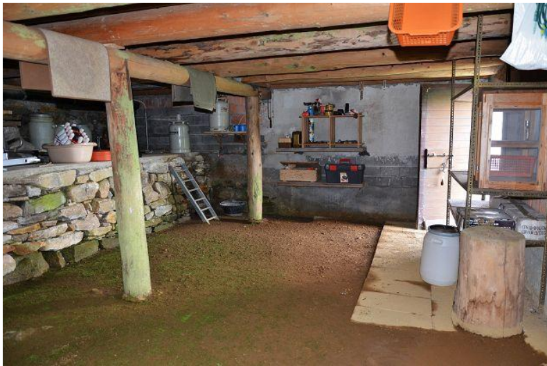
Innenraum Erdgeschoss / interno PT
