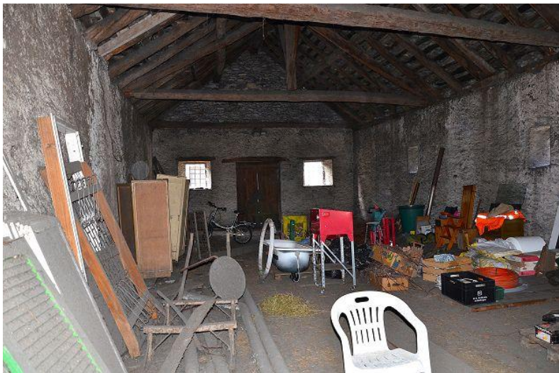
Innenraum Obergeschoss / interno primo piano
