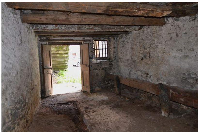
Innenraum Nebengebäude / interno casa annesso
