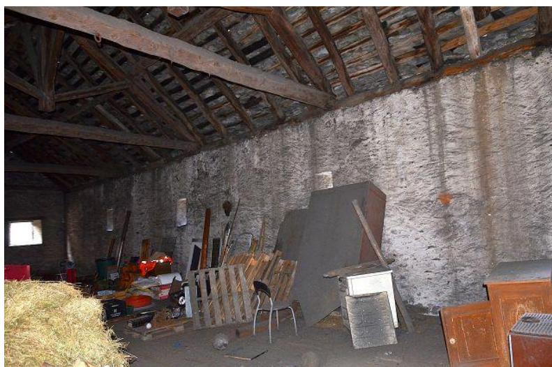
Innenraum Obergeschoss / interno primo piano
