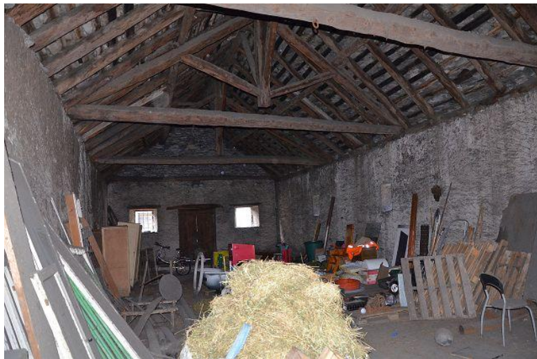
Innenraum Obergeschoss / interno primo piano
