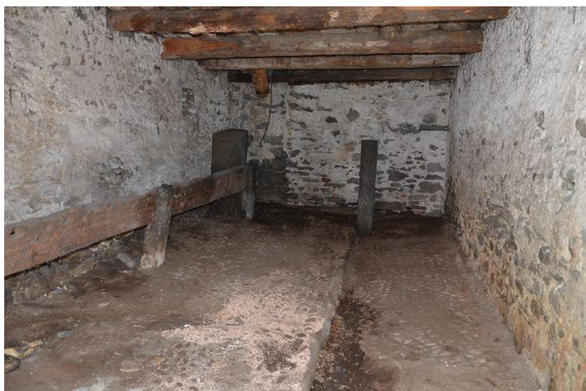
Innenraum Nebengebäude / interno casa annesso
