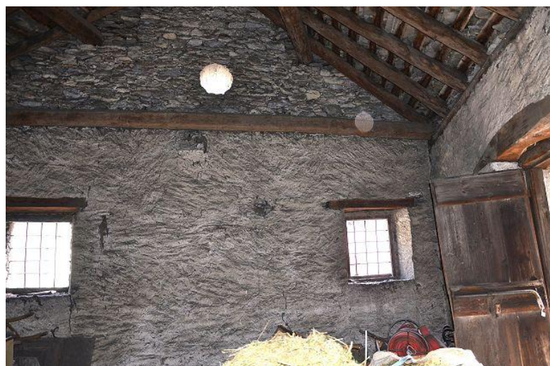
Innenraum Obergeschoss / interno primo piano
