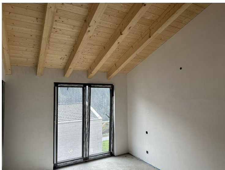
Dachzimmer / camera sotto tetto
