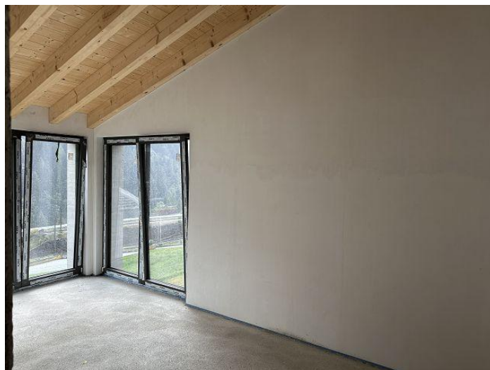
Dachzimmer / camera sotto tetto
