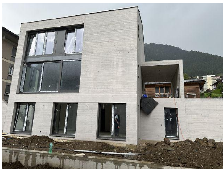
Südfassade / facciata sud
