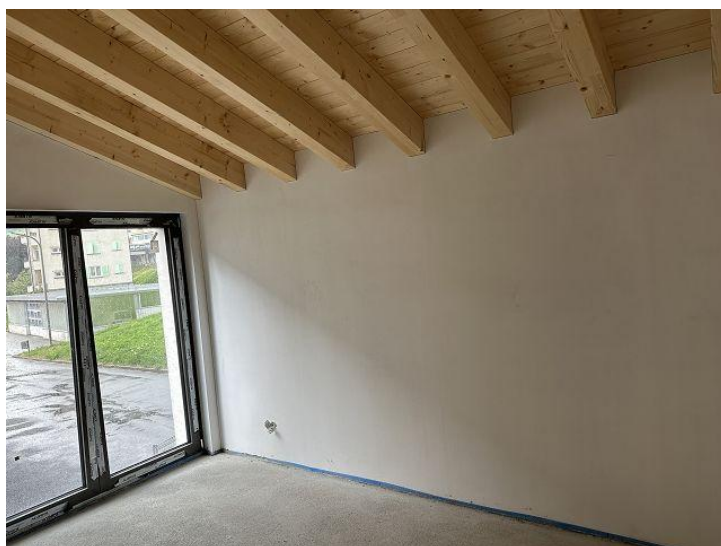
Dachzimmer / camera sotto tetto
