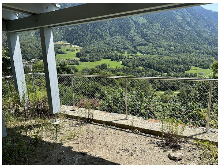
Terrasse im Erdgeschoss / terrazza nel PT
