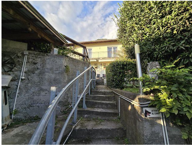
Aufgang / scala esterna
