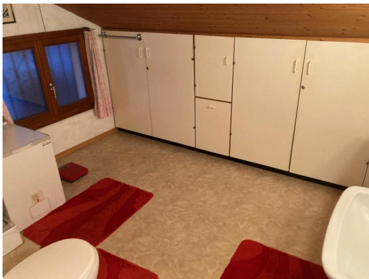
Bad im EG / bagno nel PT
