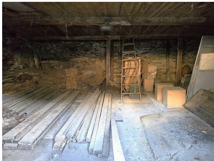
Innenraum EG / interno PT
