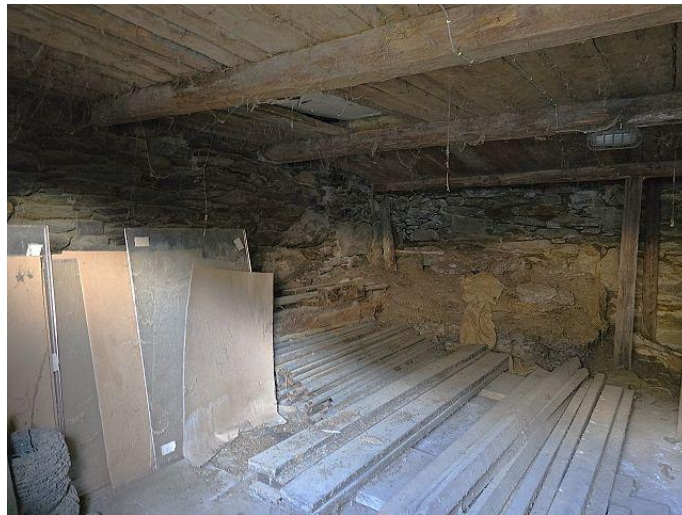
Innenraum EG / interno PT
