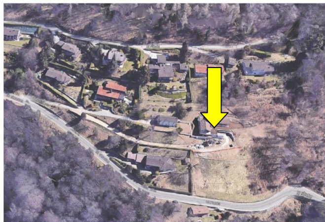
Figura 4 Comparto di studio- Veduta aerea da ovest (Fonte: Googlemaps)
