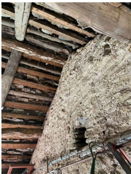
Unterdach und Mauerwerk / sotto tetto e muro
