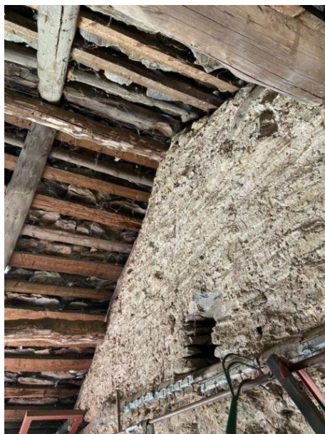
Unterdach und Mauerwerk / sotto tetto e muro
