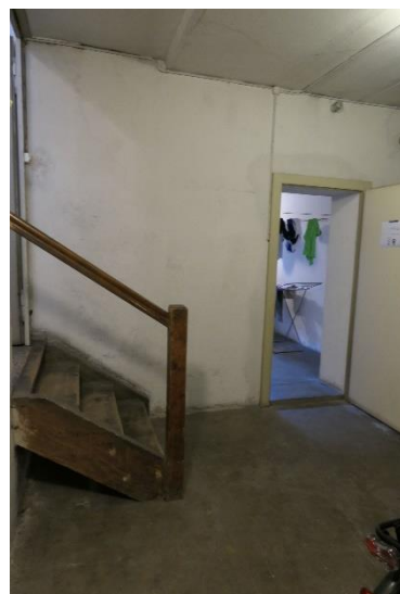
weitere Treppe zu Vorplatz
