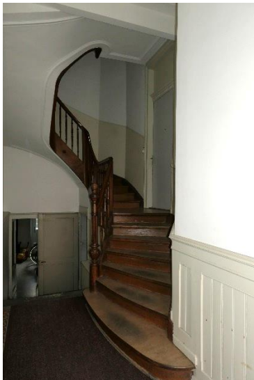
Halbgeschoss: Treppe zu Wohnung EG
