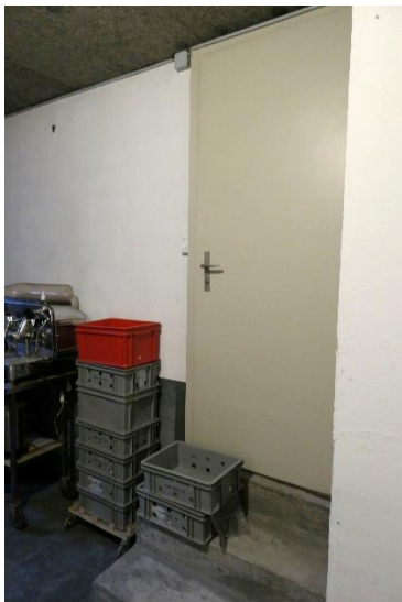
Heizungsraum: Zugang zu Garage
