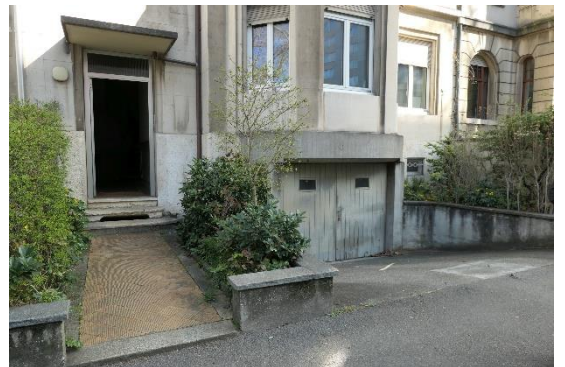
Eingangsbereich mit Garagenabfahrt
