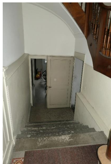
Treppe zu UG
