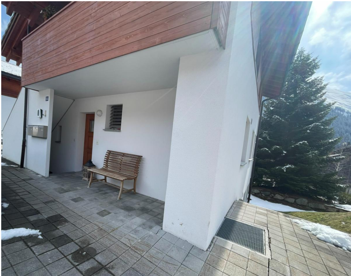
Eingangsbereich mit Aussenparkplätze
