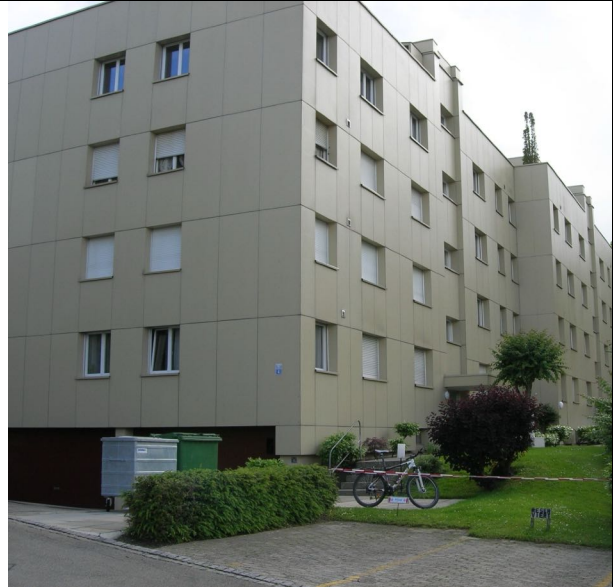
Haus Ost und Nordseite
