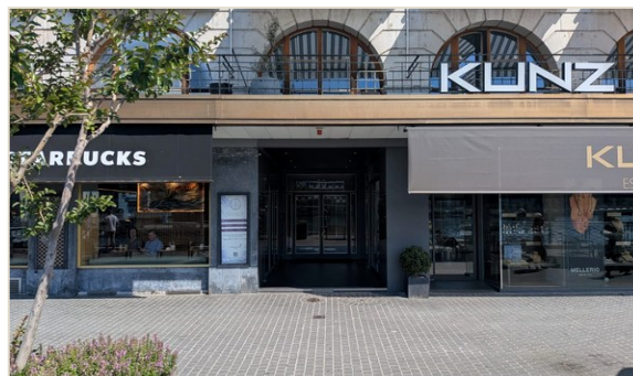
Façade et accès de l'immeuble
