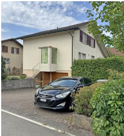
Hauszufahrt | 2 Parkplätze vor dem Haus
