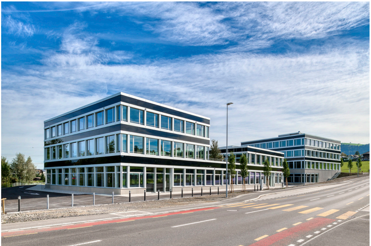
Kreuzung Dorf-, Hauptstrasse in Richtung Dorfzentrum Buchrain
