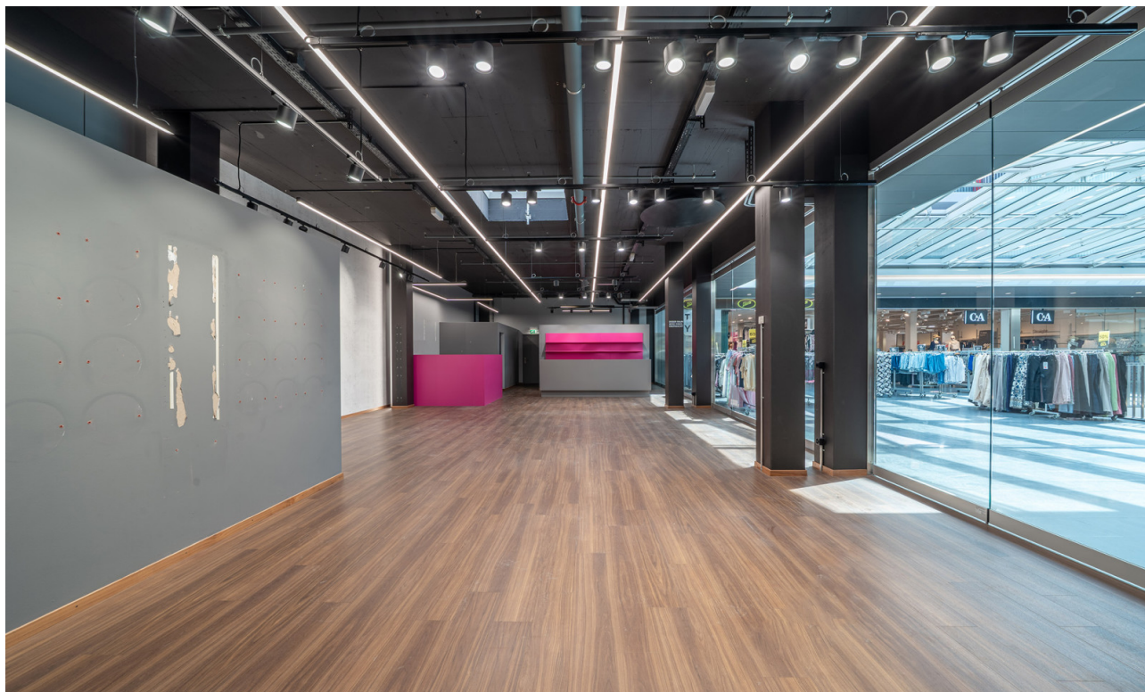
Bestehender Innenausbau - Ladenfläche
