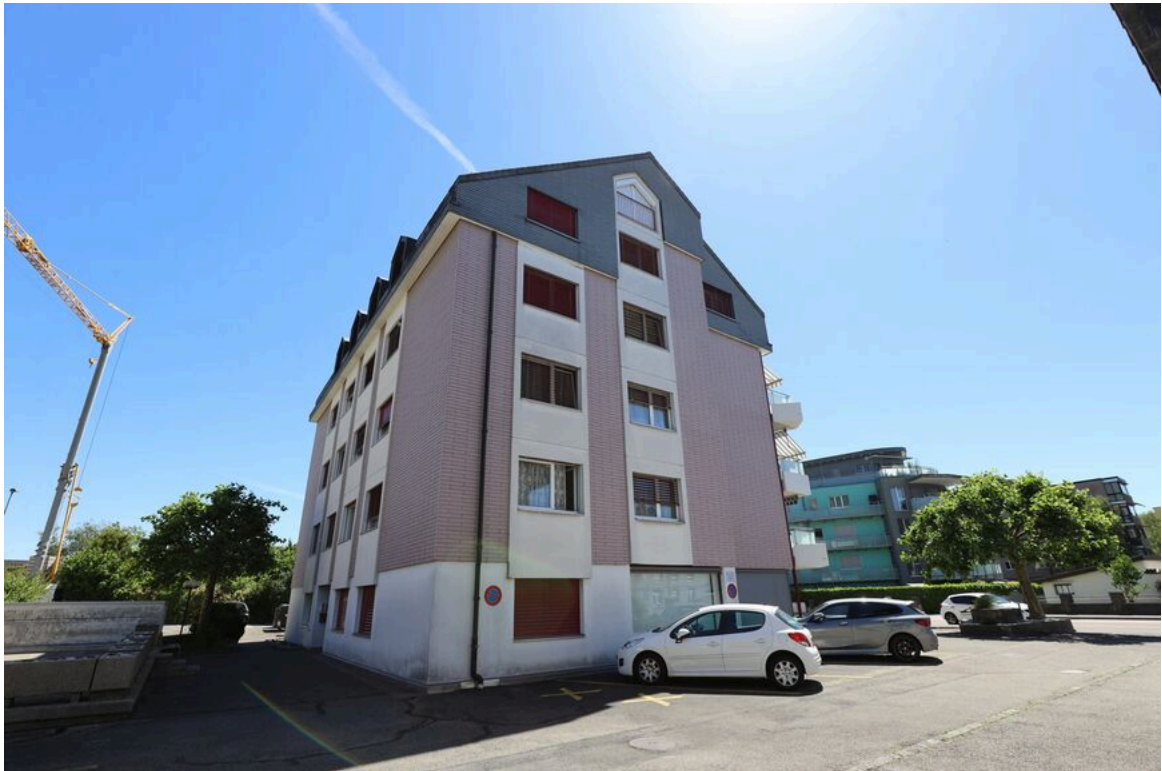
Façades nord et ouest
