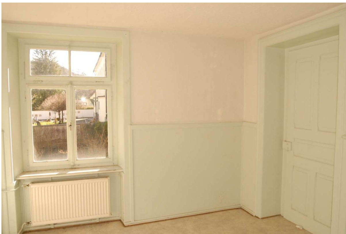
Chambre de l'étage de l'appartement du bâtiment Sud-Est
