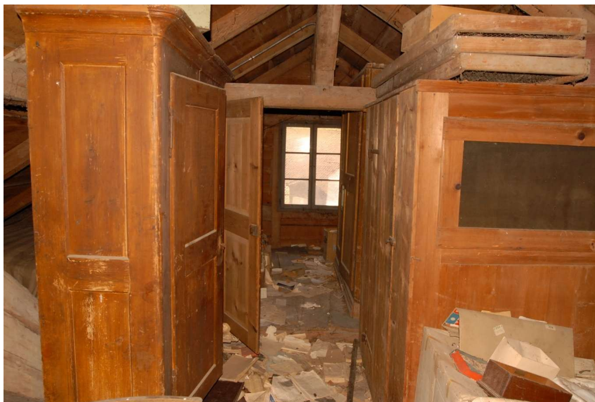
Autre vue sur le galetas des combles
