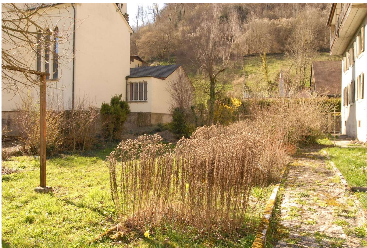
Jardin avec la citerne à gaz qui est enterrée
