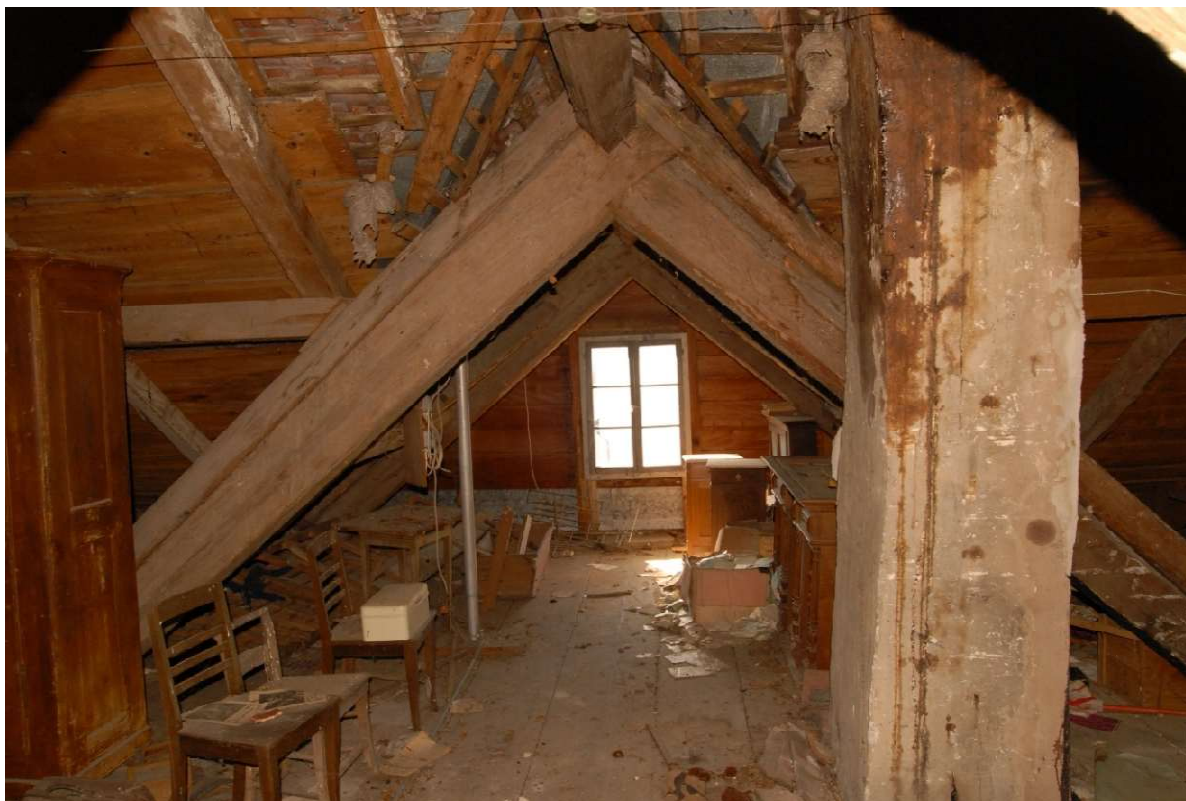
Galetas aux combles
