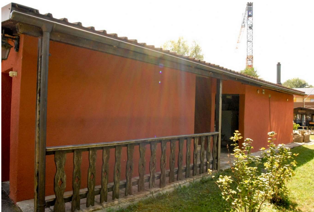
Vue de la façade Nord-Ouest
