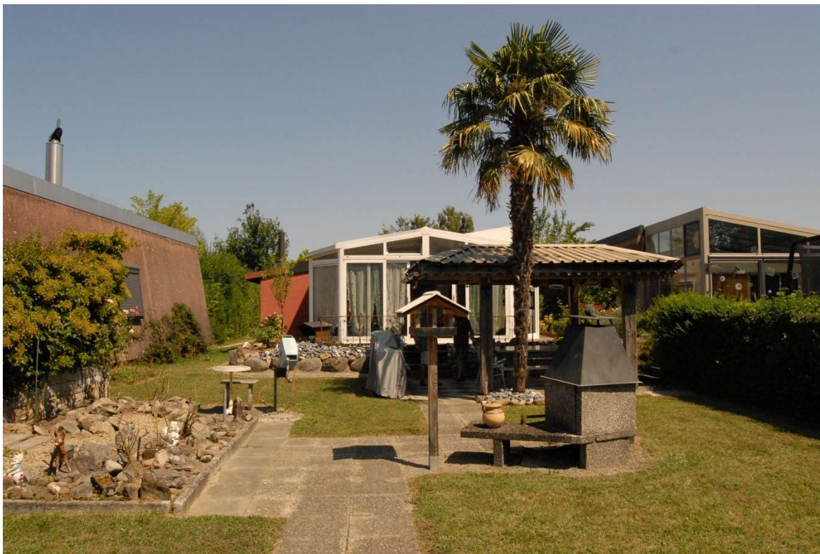
Vue façade Sud-Ouest
