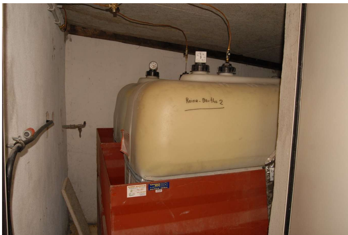
Local Citerne au rez-de-Chaussée
