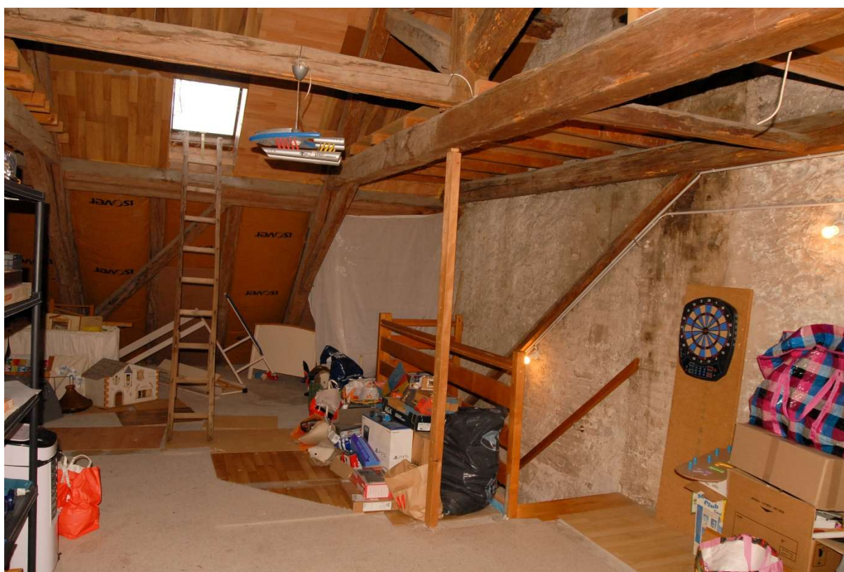
Autre vue sur le galetas des combles
