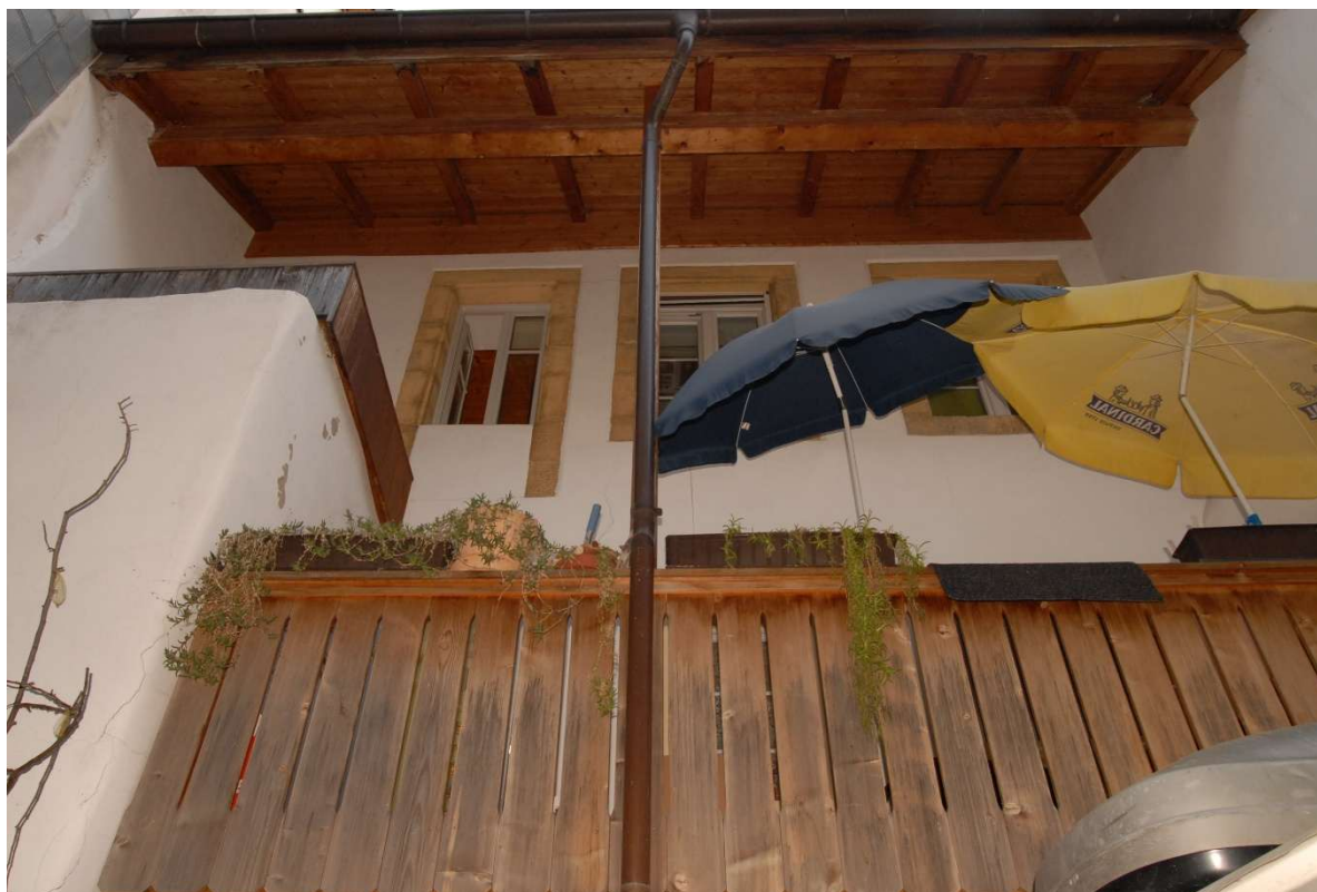
Vue de la façade Nord-Ouest de la cours intérieur
