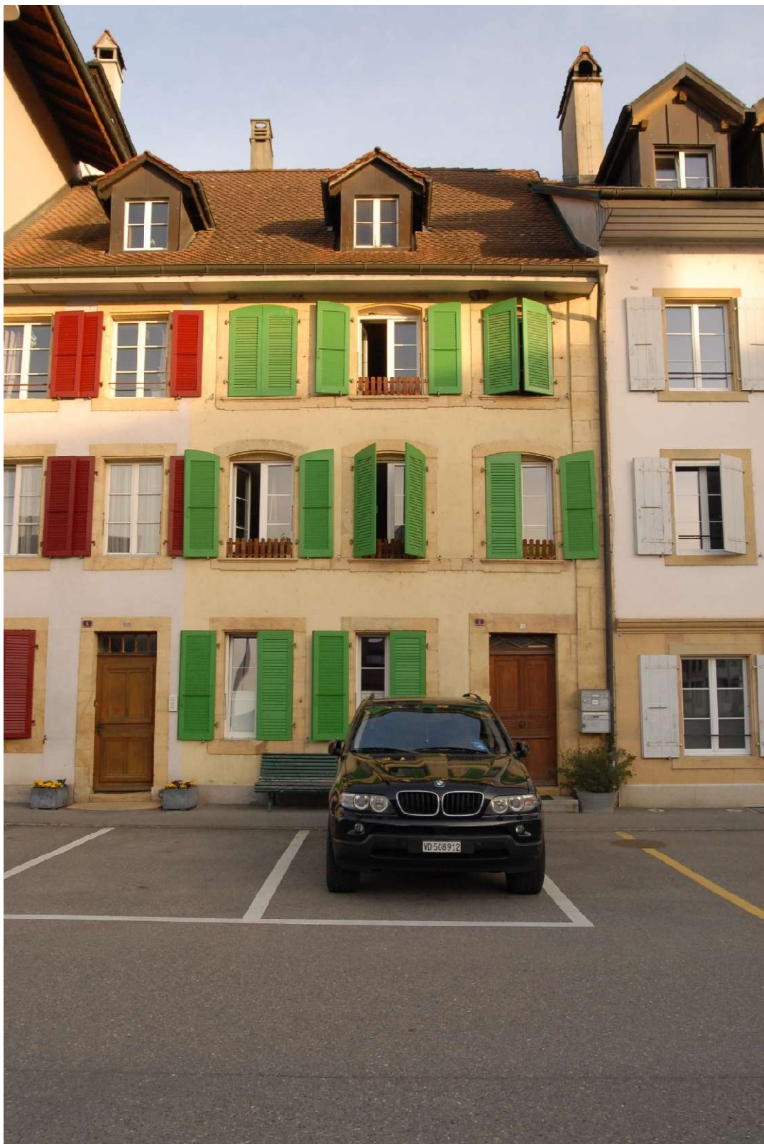
Vue de la façade Sud-Est
