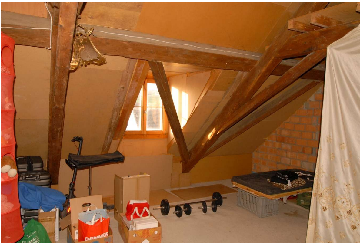
Galetas au combles
