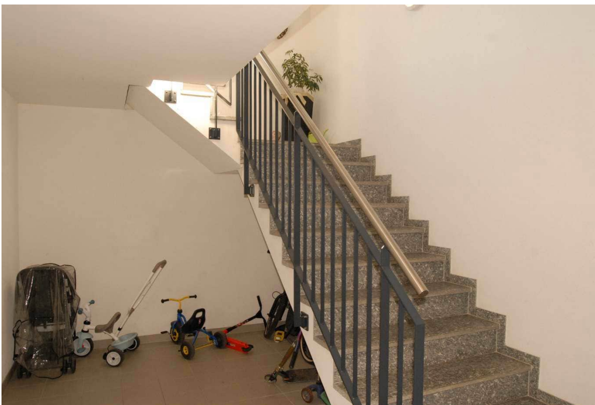
Cage d'escalier de l'immeuble
