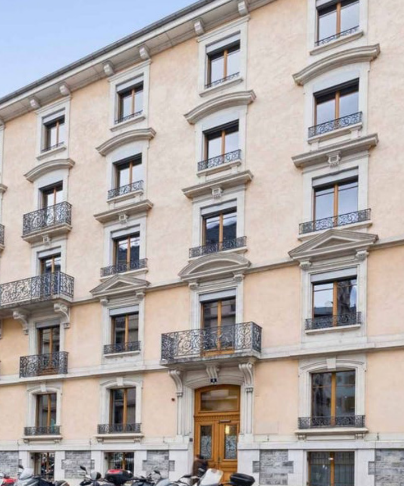
Façade du bâtiment
